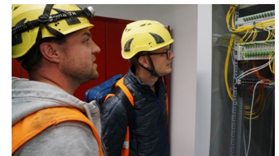
Bauleiter Samuel Anneler erklärt Christian Hunziker, Leiter Swiss Projects, die Glasfaser-Infrastruktur.
