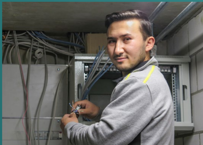
Besmi beim Ausführen der elektrotechnischen Arbeiten in einem Einfamilienhaus.
